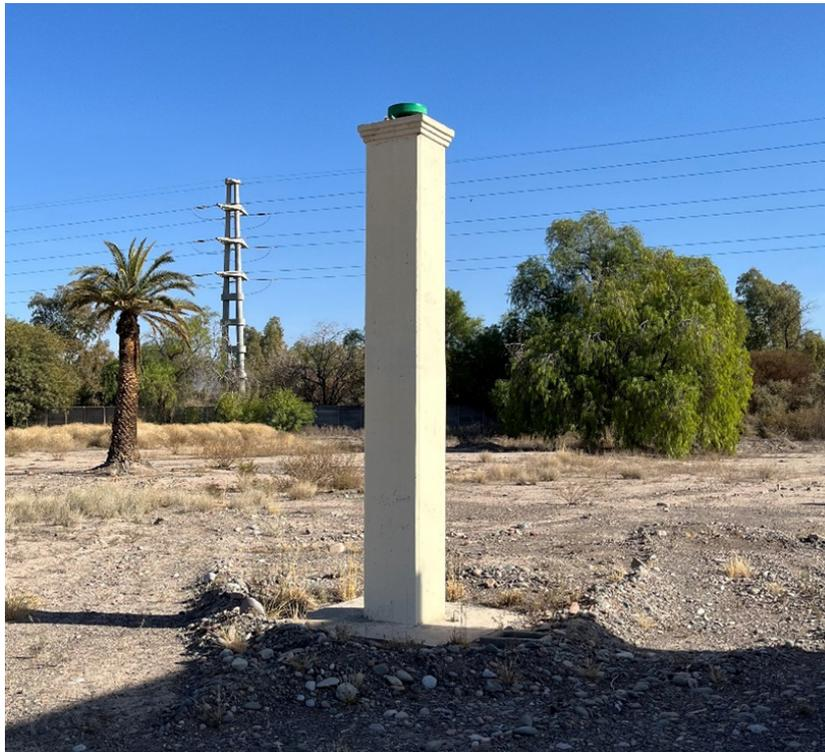
Figura 2: Pilar punto OAFA (Antena GNSS)
