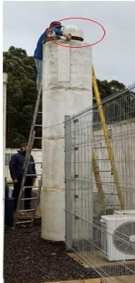
Figura 2. Punto E (Pilar GNSS)
