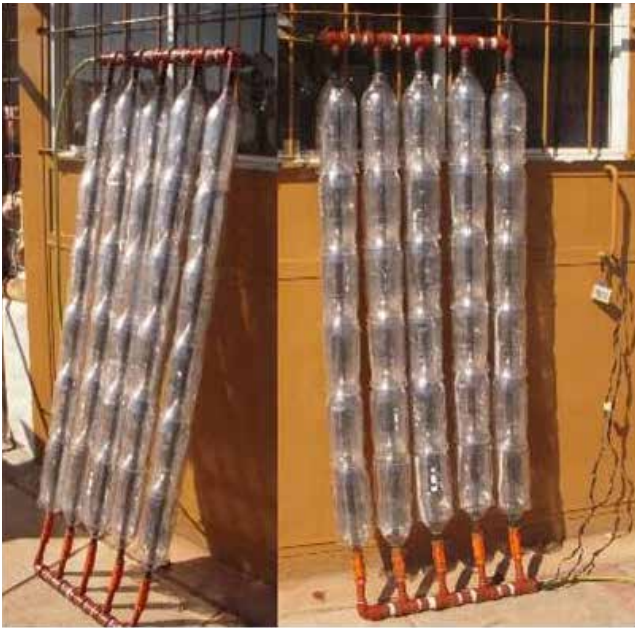
Figura 2 Imágenes del colector terminado con un Tanque de almacenamiento sin aislar. Fuente: elaboración propia (Mendoza, 2010)
